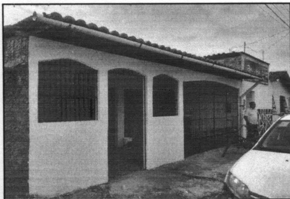
Foto 01: Vista da Fachada do Imóvel
