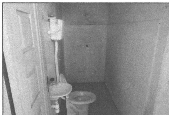
Foto 06: Imagem do Banheiro, com destaque a louças e revestimento cerâmico em piso e paredes.
