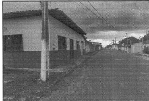
Foto 02: Imagem da rua de acesso ao imóvel com pavimentação
