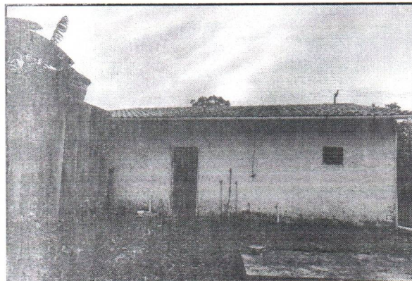
Foto 14: Vista Posterior do Imóvel, com estrutura em concreto para caixa d' água
