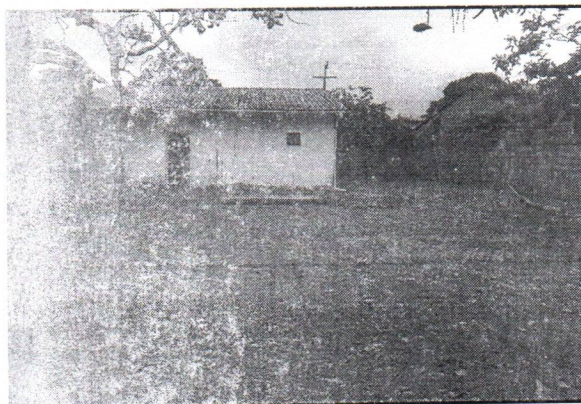
Foto 16: Vista do Quintal do Imóvel
