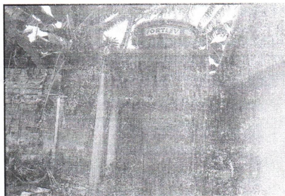
Foto 15: Imagem da estrutura da caixa d' água
