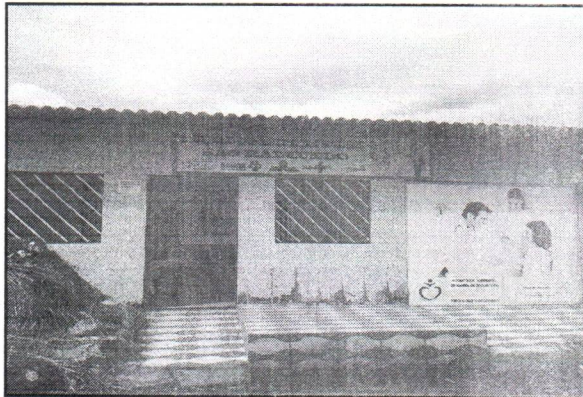
Foto 01: Vista da Fachada do Imóvel, com calçada e esquadrias em alumínio
