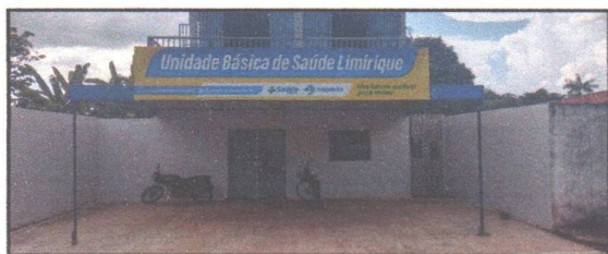
Foto 01: Vista da Fachada do Imóvel, com área de estacionamento e esquadrias em alumínio e vidro
