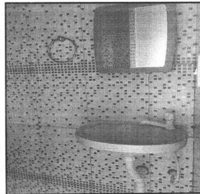
Foto 12: Imagem de banheiro com pia em louça e parede revestida
