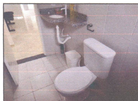
Foto 06: Imagem do banheiro, com revestimento cerâmico em piso e paredes.
