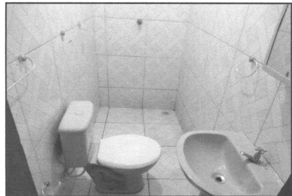
Foto 06: Vista Banheiro, com destaque ao revestimento cerâmico em paredes e piso.
