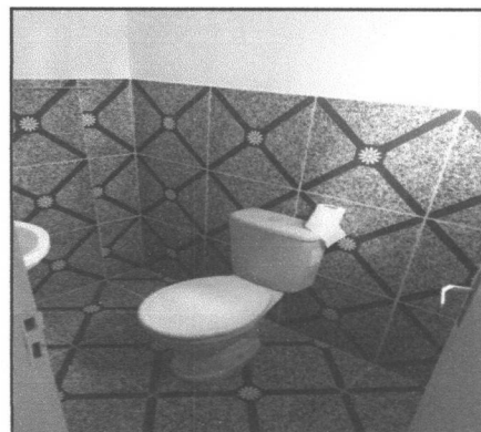
Foto 06: Vista da Banheiro, com destaque ao revestimento cerâmico em paredes e piso
