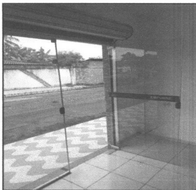
Foto 03: Vista da Entrada do Imóvel, com destaque a porta de vidro com esquadrias de alumínio.
