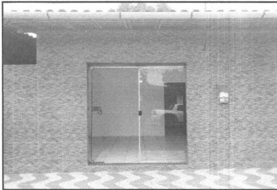
Foto 01: Vista da Fachada do Imóvel
