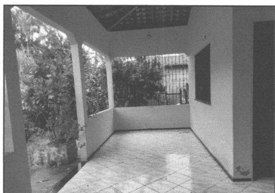
Foto 05: Vista do Terraço, com destaque para o revestimento cerâmico
