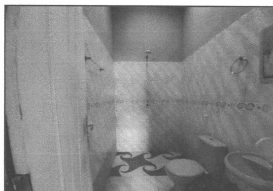
Foto 06: Vista Banheiro, com destaque ao revestimento cerâmico em paredes e piso.
