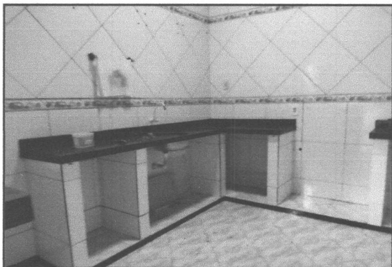
Foto 07: Vista da Cozinha
