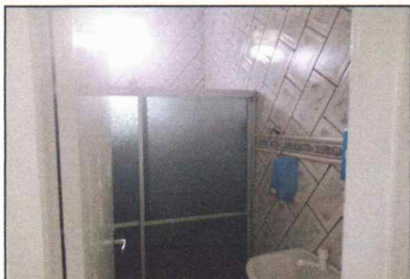
Foto 05: Imagem do banheiro, com destaque ao revestimento cerâmico de paredes e piso.
