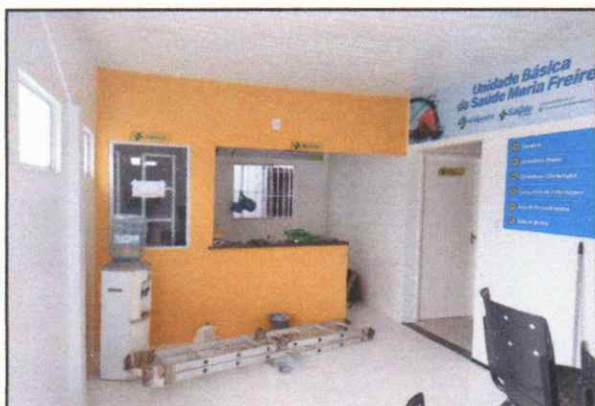
Foto 03: Vista da Recepção, com destaque a bancada em granito e piso cerâmico.
