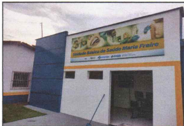
Foto 02: Vista da Fachada do Imóvel, com porta de entrada em vidro
