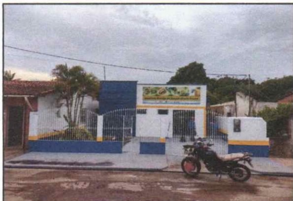
Foto 01: Vista da Fachada do Imóvel, com destaque aos portões de gradil
