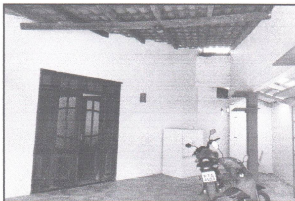
Foto 05: Vista da Garagem, com destaque as esquadrias em madeira
