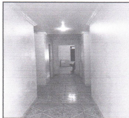
Foto 08: Imagem da área de Circulação das Salas, com piso cerâmico, pintura em tinta látex e forro em gesso
