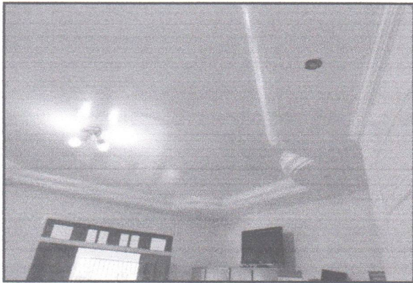
Foto 07: Vista do Forro em Gesso para área de Recepção
