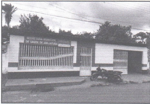
Foto 01: Vista da Fachada do Imóvel
