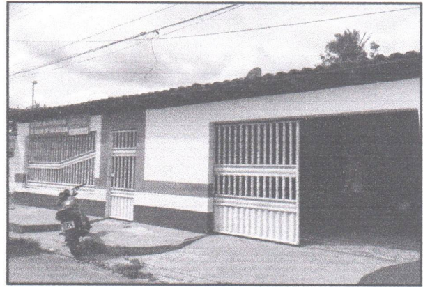
Foto 02: Vista da Fachada do Imóvel, com destaque aos portões de entrada em alumínio
