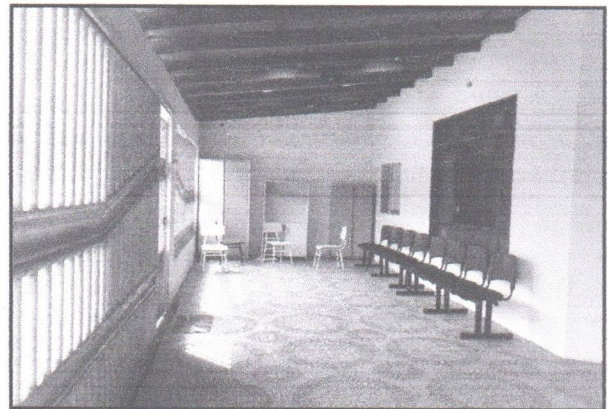
Foto 04: Imagem da Garagem/Área de Espera, com destaque ao piso cerâmico e cobertura com trama de madeira e telha cerâmica
