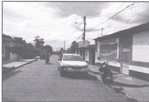
Foto 03: Vista da Rua de Acesso ao Imóvel
