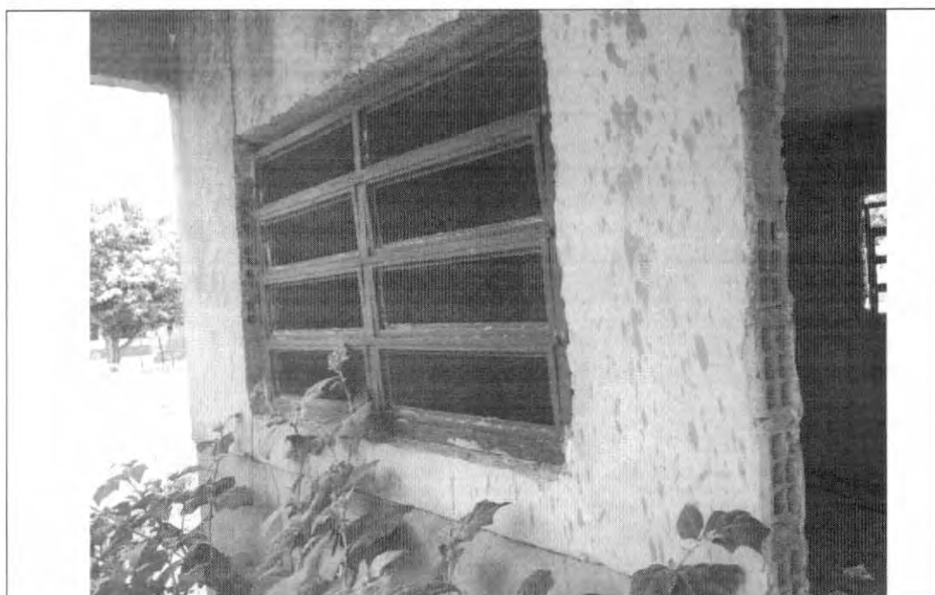
ESQUEDRIAS EXECUTADAS EM PERFEITAS CONDIÇÕES DE USO.
