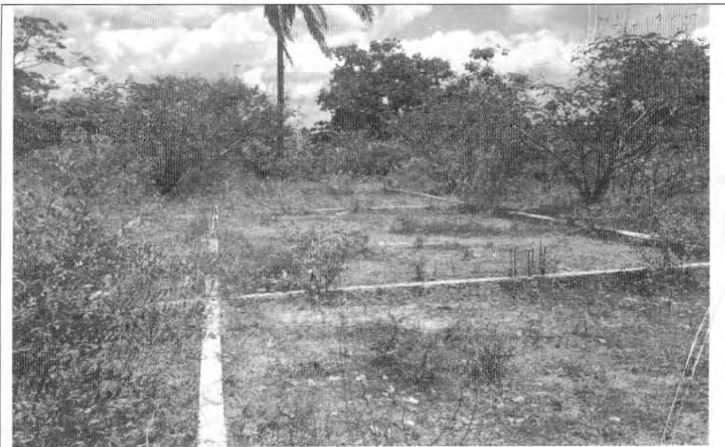
PARTE DE ALVENARIA E SUPERESTRUTURA A SER EXECUTADA DO BLOCO PEDAGOGICO.
