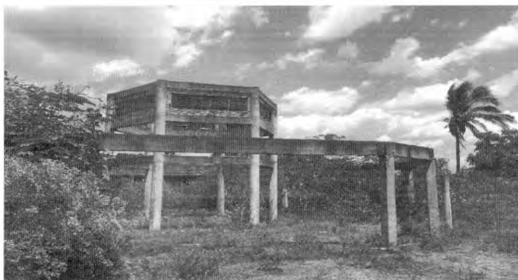
CORETO DA ESCOLA EM FASE DE CONCLUSÃO
