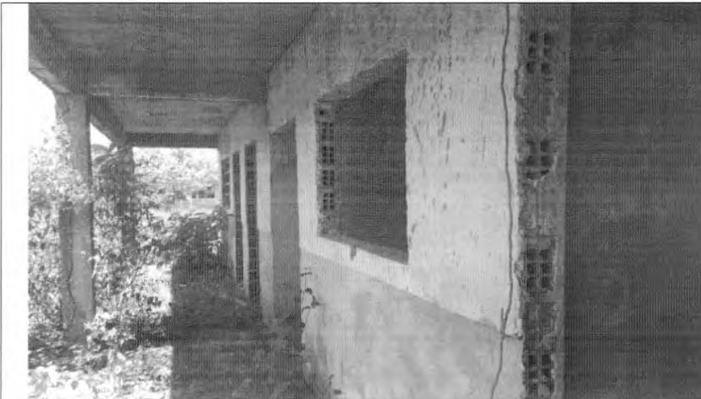
ALVENARIA EXECUTADA EM CONFORMIDADE.
