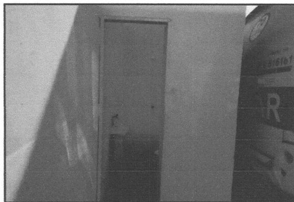
Foto 06: Vista do Banheiro do Imóvel.
