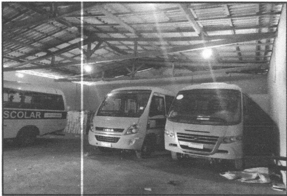
Foto 03: Vista da Galpão, com destaque a cobertura com estrutura com trama de madeira e telha de fibrocimento.
