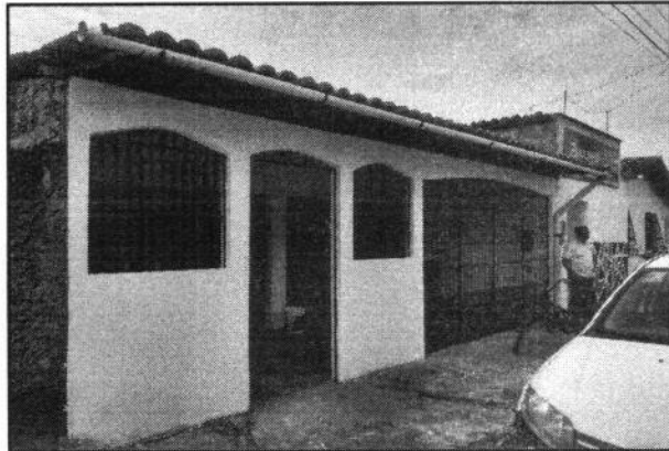
Foto 01: Vista da Fachada do Imóvel
