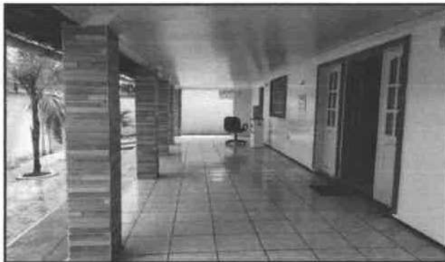
Foto 03: Vista da Varanda, com destaque a esquadria em madeira, piso cerâmico e forro em gesso
