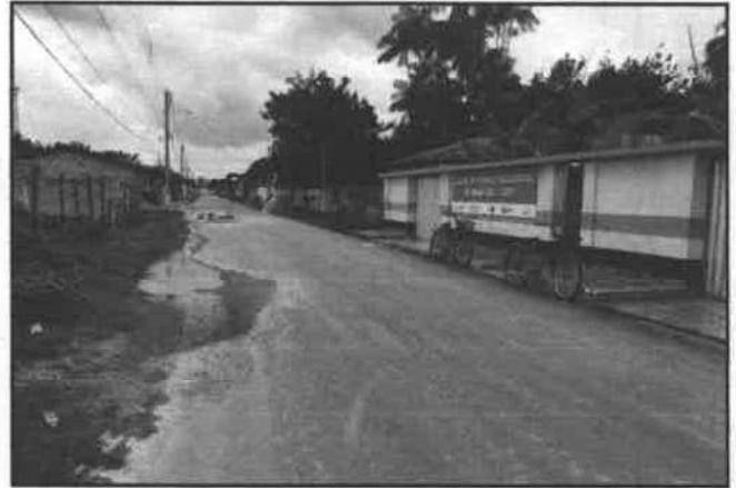
Foto 02: Vista da rua de acesso ao Imóvel
