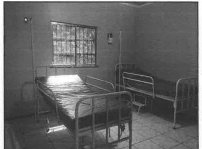
Foto 06: Imagem da Sala de Observação, com piso cerâmico e janelas em alumínio e vidro, com gradil.
