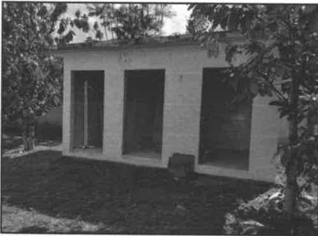
Foto 07: Vista de depósito construído no quintal do imóvel, com paredes e piso revestido de cerâmica
