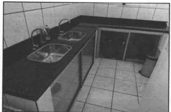
Foto 10: Imagem da bancada em granito para área de cozinha, com pias duplas em aço inox.
