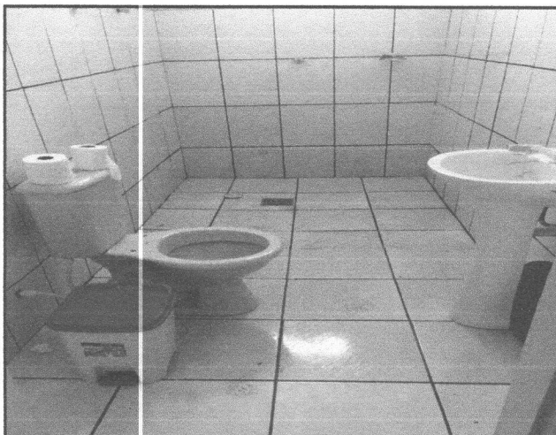
Foto 05: Banheiro com pia em louça e sanitário, constituído de piso e paredes revestidos de cerâmica
