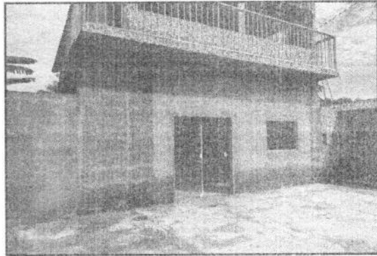
Foto 01: Vista da Fachada do Imóvel, com área de estacionamento e esquadrias em alumínio
