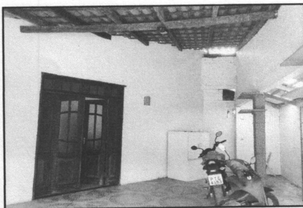
Foto 05: Vista da Garagem, com destaque as esquadrias em madeira
