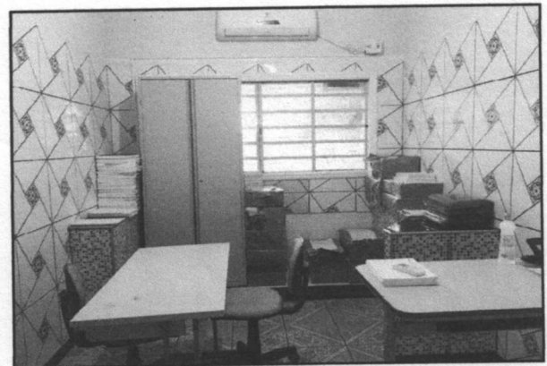
Foto 10: Imagem de sala climatizada, com piso e paredes revestidas com cerâmica, bancada em granito e janela em alumínio e vidro
