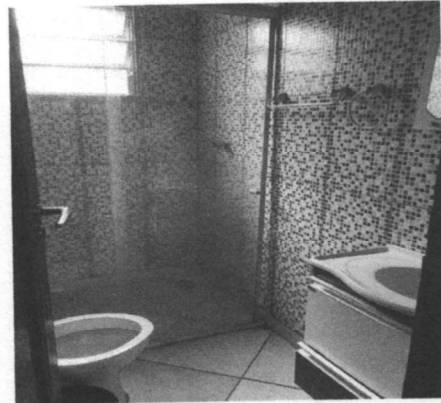
Foto 14: Imagem de Banheiro, com bancada, box de vidro, piso e paredes revestido com cerâmica
