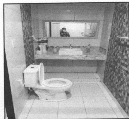
Foto 12: Imagem de Banheiro, com bancada em granito, espelho, piso e paredes revestido com cerâmica
