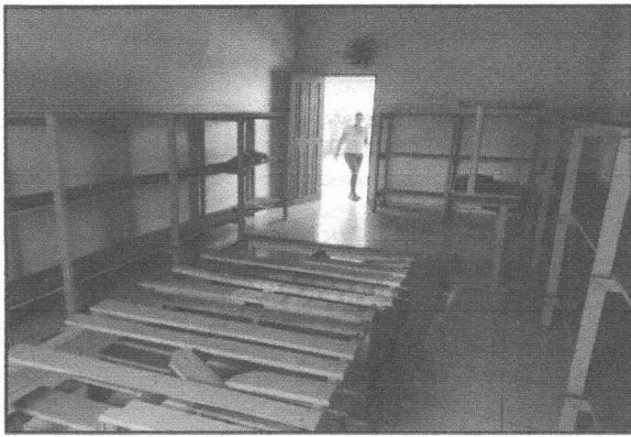
Foto 16: Sala do anexo, com piso em cerâmica
