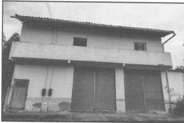
Foto 01: Vista da Fachada do Imóvel
