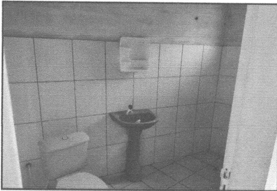
Foto 10: Banheiro pavimento superior, com revestimento cerâmico em piso e paredes
