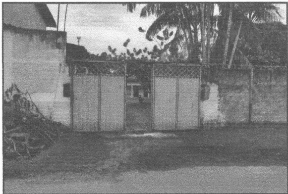
Foto 20: Portão de entrada ao prédio anexo
