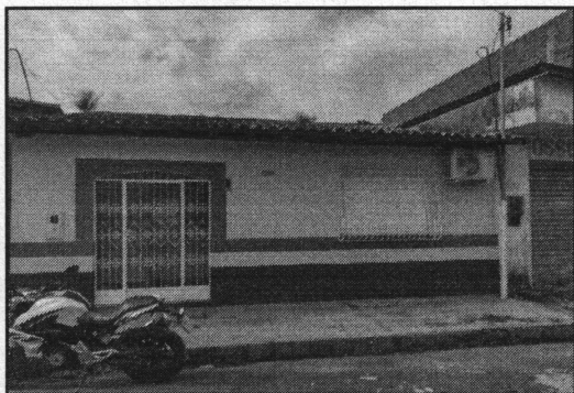
Foto 01: Vista da Fachada do Imóvel
