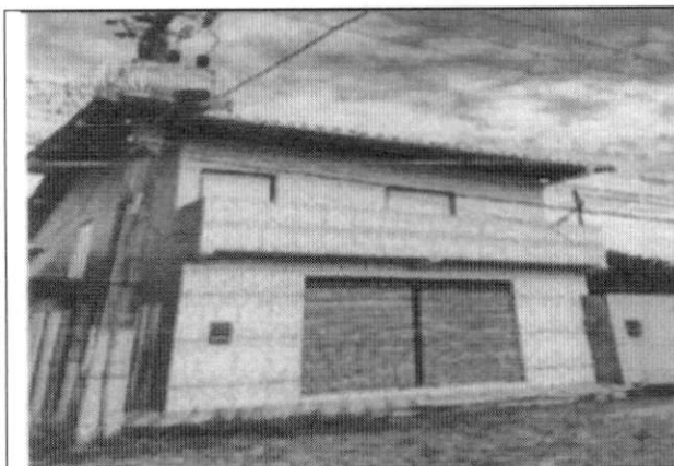
Foto 01 – Fachada do imóvel
