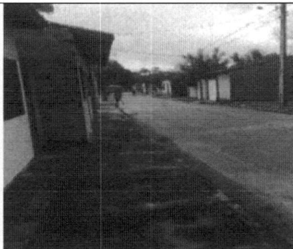
Foto 02 – Acesso ao imóvel
